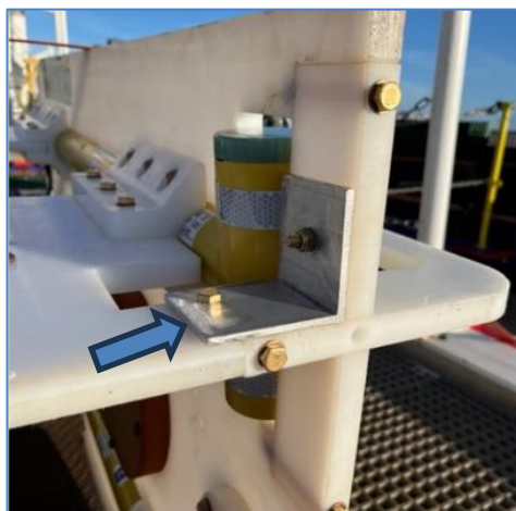
Рисунок 2.1 Расположение алюминиевого элемента рядом с датчиком магнитного поля
